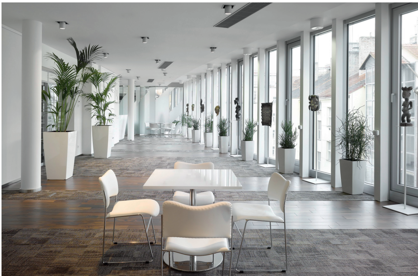
Ocelové sloupy s obkladem deskami PROMATECT®
